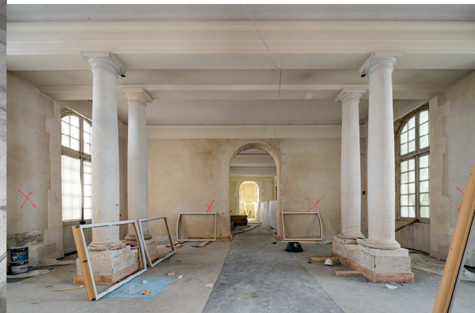
Curetage de la Salle des colonnes, au RDC. ©OPPIC - P. Tourneboeuf
