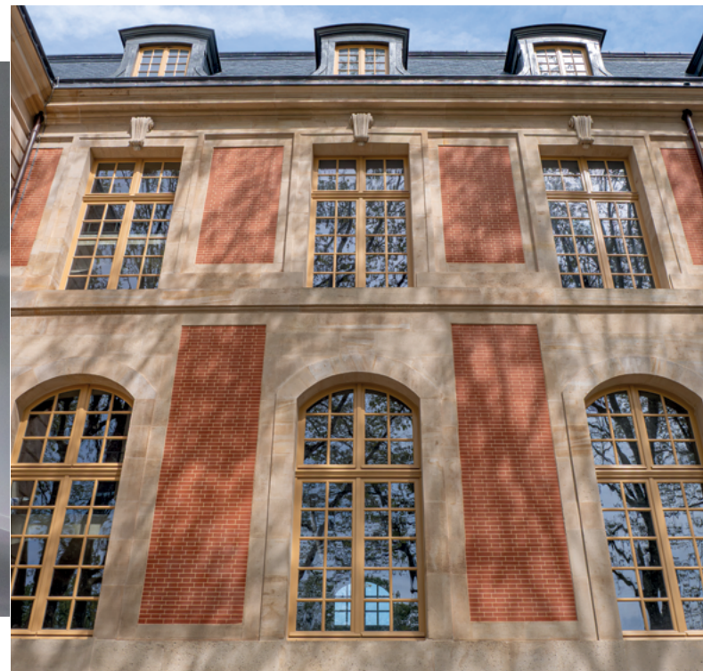
Façade avenue de Sceaux, parements de fausses briques ©C2RMF - B. Viscaino
