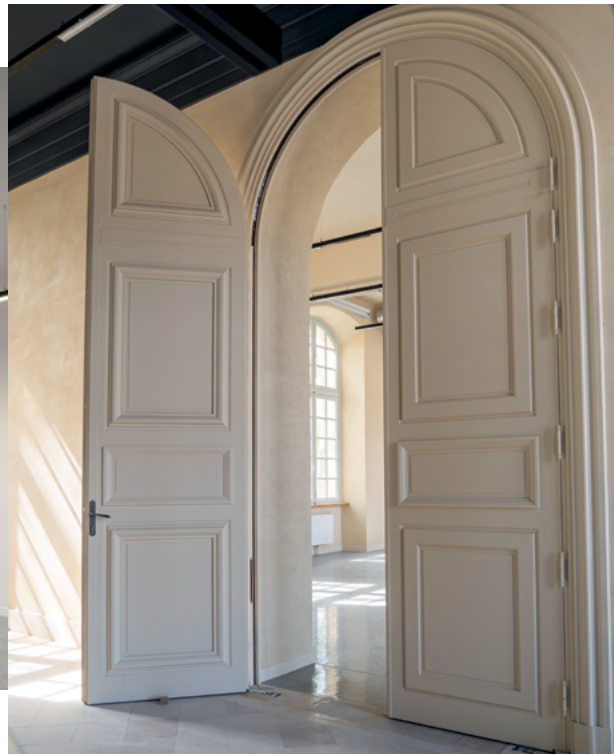
Double porte recrée et sécurisée, RDC, aile de Sceaux ©C2RMF - B. Viscaino
