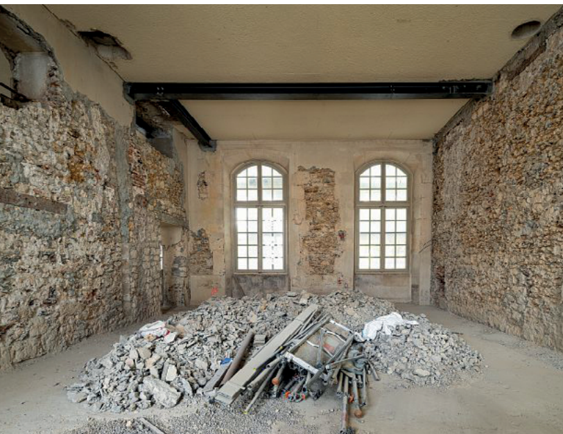
Dégagement des enduits ©OPPIC - P. Tourneboeuf
