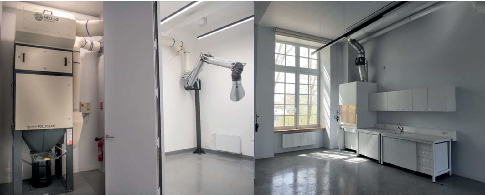
époussiereur et bras aspirant, salle laser, aile de Sceaux ©C2RMF - Ph. Salinson
