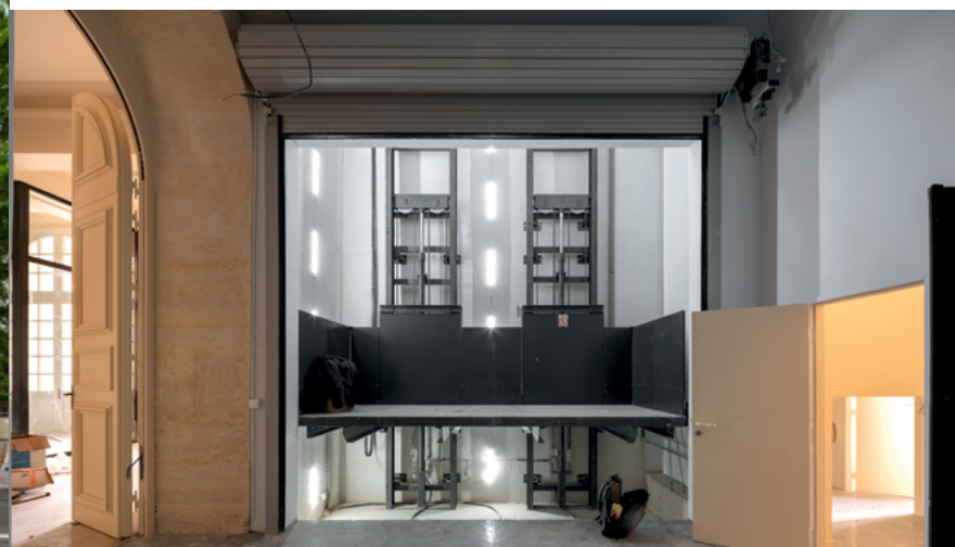
Nouveau monte-charge, aile de Sceaux ©OPPIC - P. Tourneboeuf
