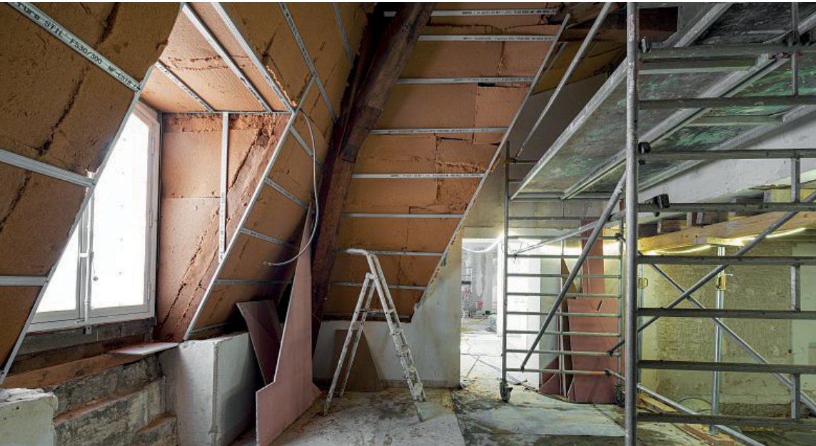
pose en place de l'isolant en fibre de cellulose pavillon de tête, aile de Sceaux ©OPPIC - P. Tourneboeuf
