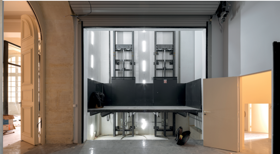
Nouveau monte-charge, aile de Sceaux ©OPPIC - P. Tourneboeuf
