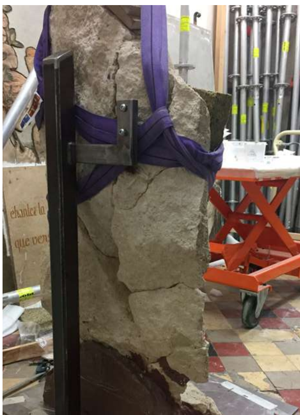
Fig. 8. Réalisation de la semelle en cours. © Amélie Méthivier.
