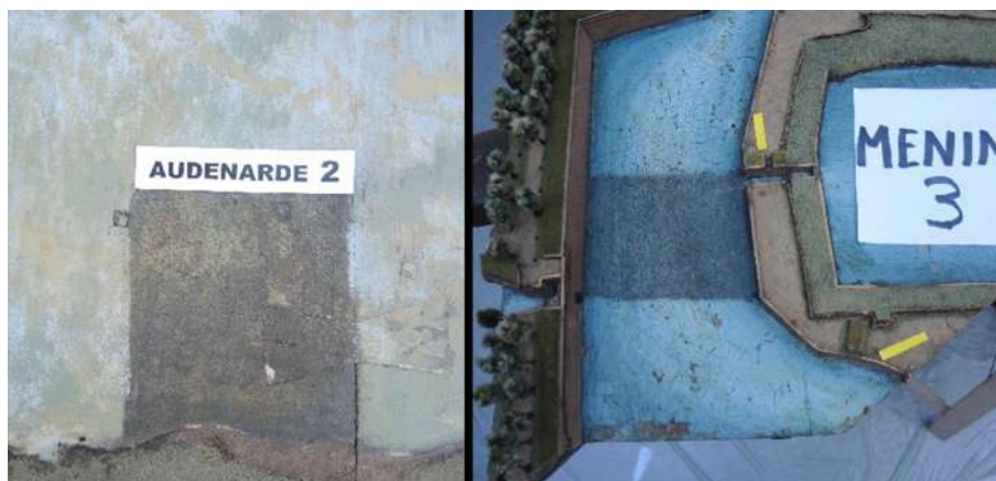
Fig. 10. Exemples de témoins de zones volontairement non traitées sur les plans-reliefs d'Audenarde et de Menin en cours de restauration en 2019. © Anne Courcelle Groupement.
