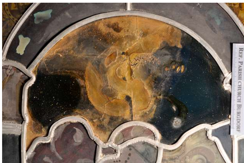
Fig. 2. Détail d'un verre brisé doublé et collé en plein avec une résine époxy dans les années 1970, à l'église paroissiale de Burgdorf (Suisse), observé dans le cadre du projet Constglass, quarante années plus tard. © Vitrocentre Romont.
