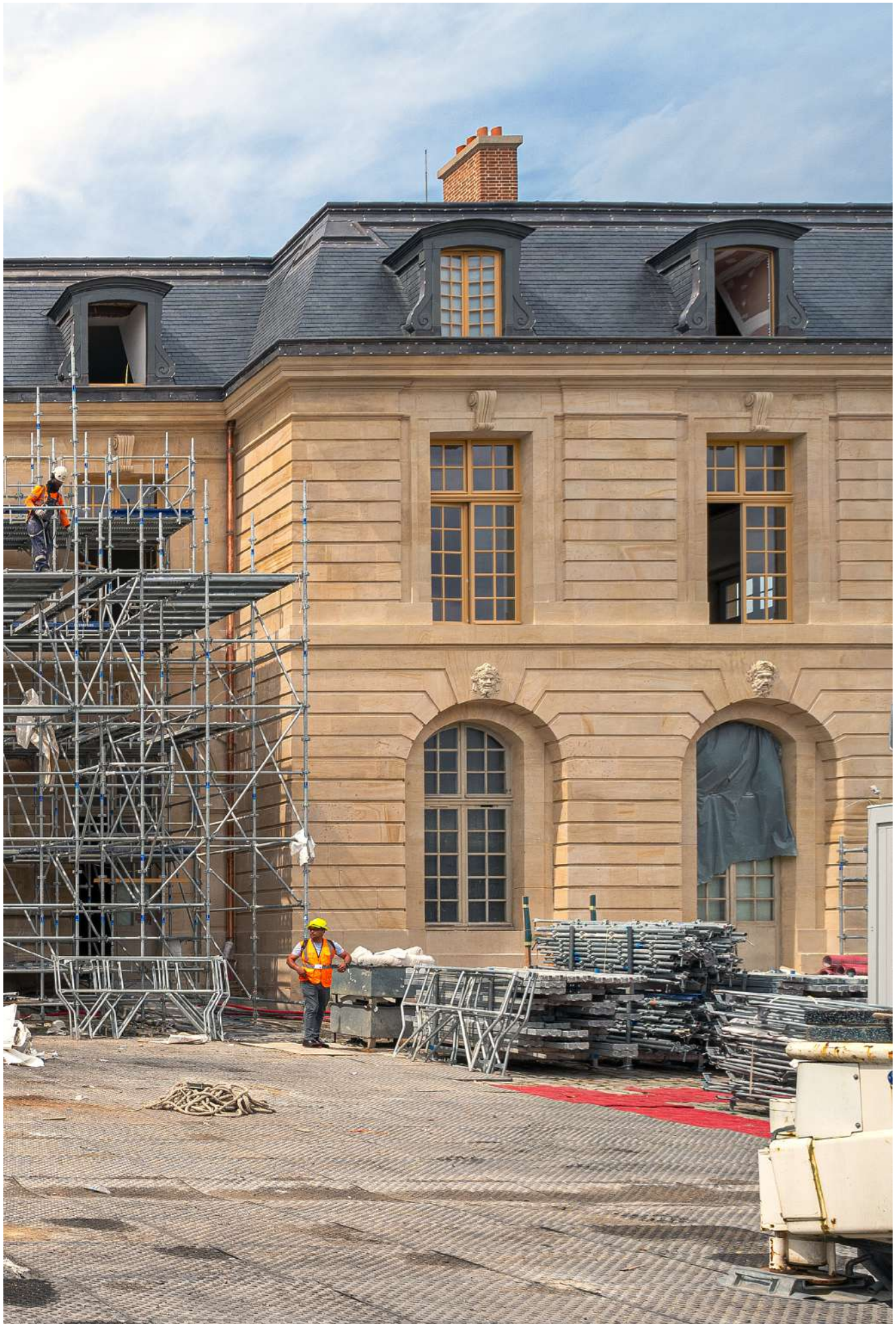
[↑] Petites écurie du roi, travaux facade cours d'Honneur ©OPPIC - Patrick Tourneboeuf
