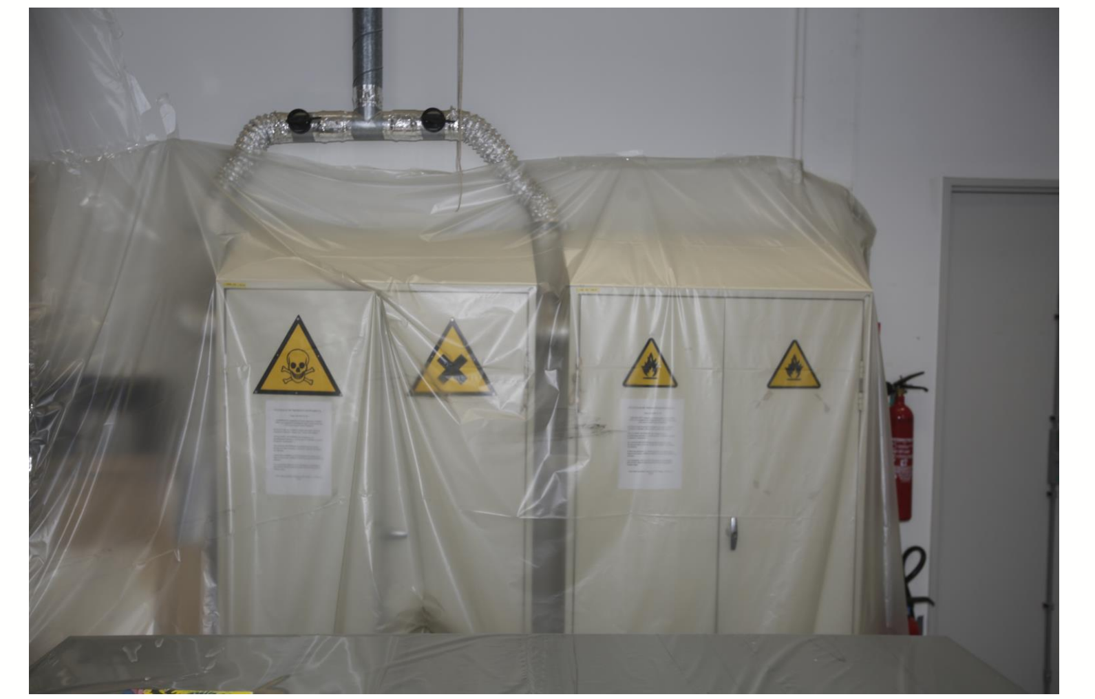
Bâchage préventif des installations sensibles**
