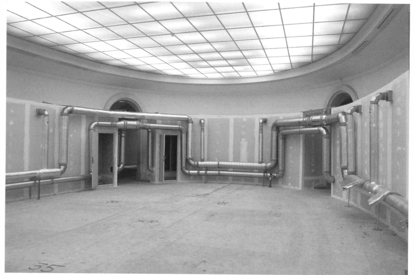
Fig. 1. Salle des Nymphéas : protection des œuvres pendant les travaux de rénovation. © R. May.
